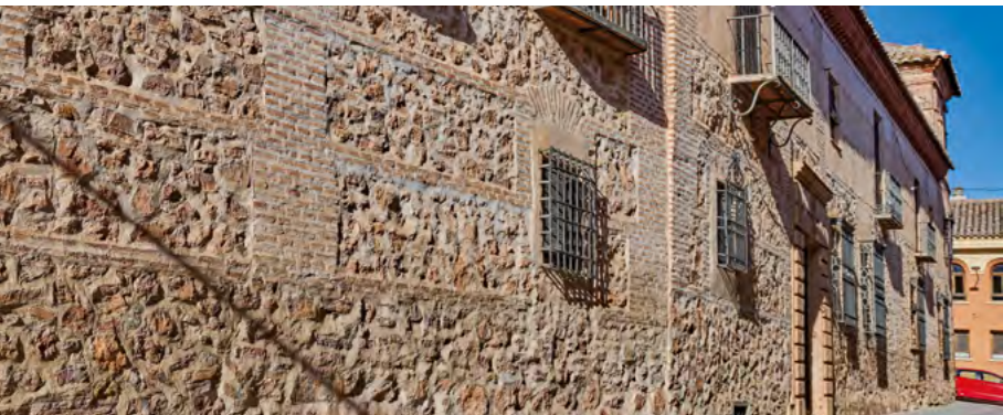
La Solana. Casa de la Encomienda.
