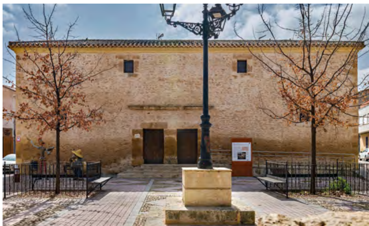
Argamasilla de Alba. Pósito de la Tercia.
